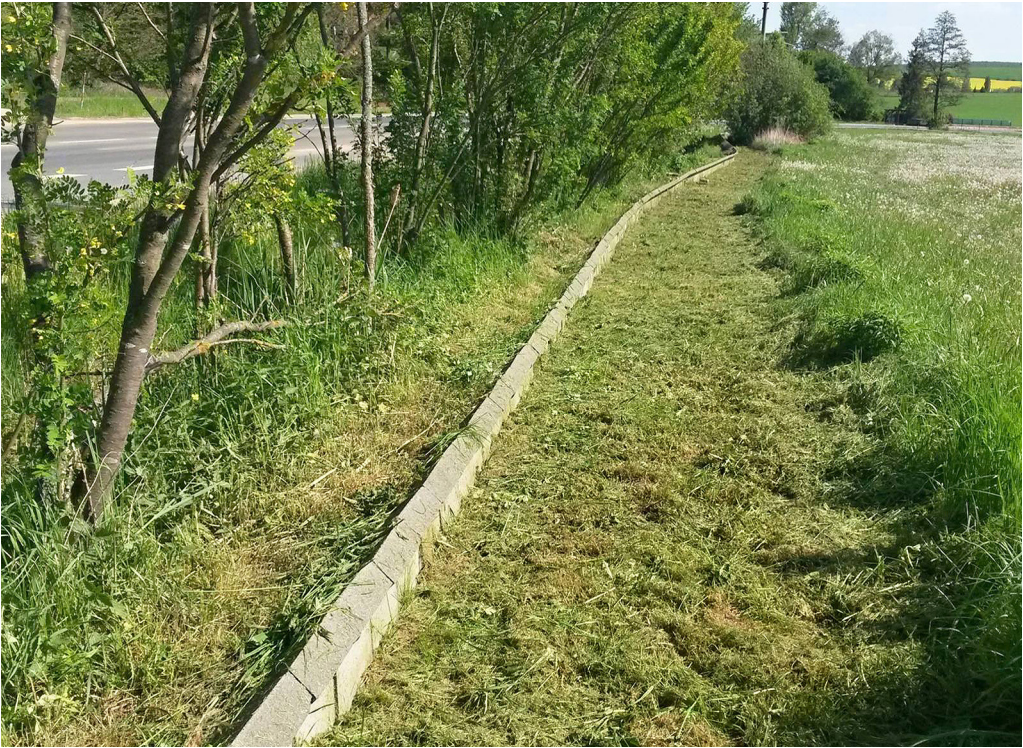
Obr. 1 Betonová zábrana s pravidelně koseným travním porostem. Foto Josef Ferenc
