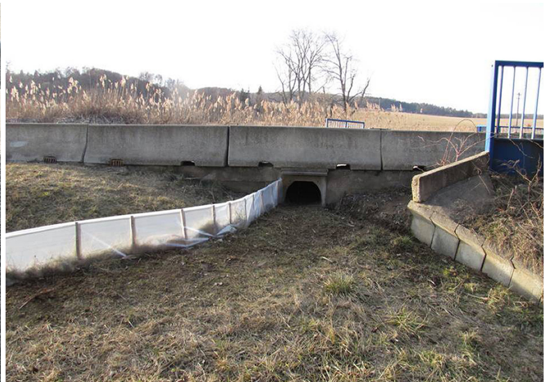
Obr. 6 Igelitová zábrana navedení do podchodu AT 500 ve tvaru budoucích betonových zábran 3. etapy. Foto Josef Ferenc
