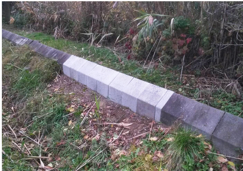
Obr. 4 Betonové zábrany opravené stavební a údržbářskou četou ÚMČ Žebětín. Foto Josef Ferenc
