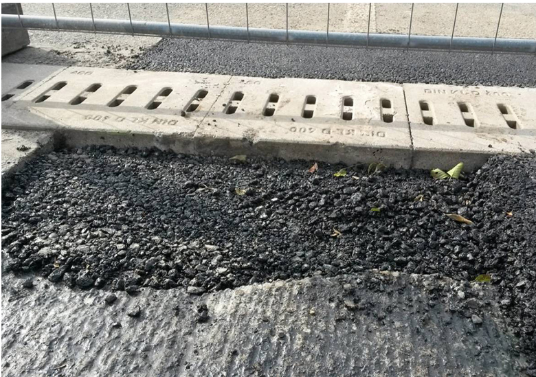
Obr. 5 Podchod AT 500 je po 16 letech provozu neporušený. Fotografie je pořízena při opravě obrusné vrstvy asfaltového povrchu komunikace. Foto Josef Ferenc
