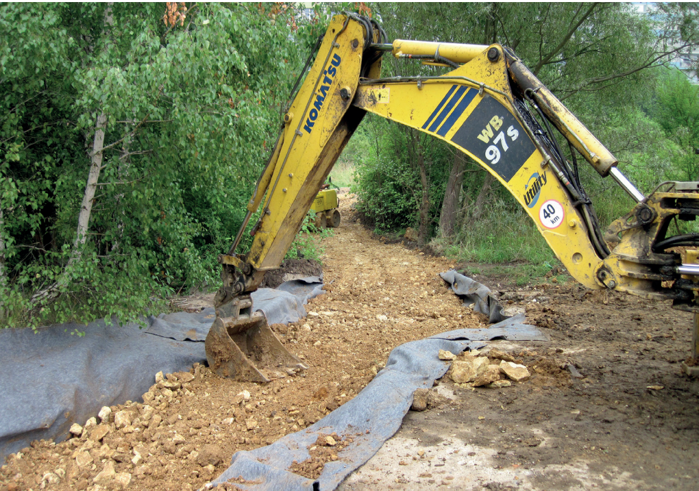
Výstavba koryta Řepského potoka. Foto Jiří Karnecki
