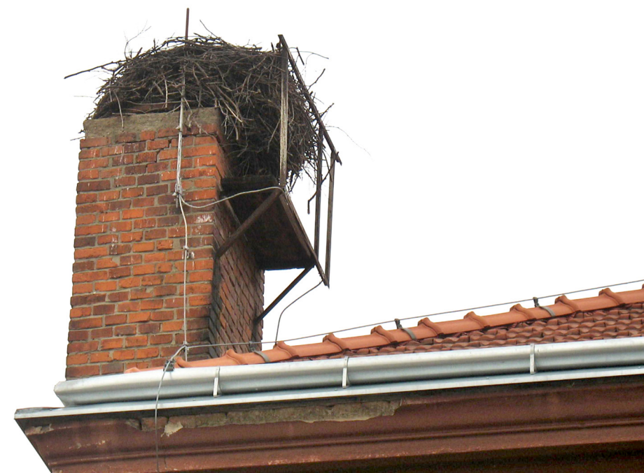
Obr. 2 Příklad hnízda bránícího užívání komínu. Foto Mojmir Vlašin
