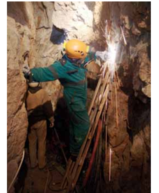
Odstraňování konzol starých elektrických zařízení v jeskyni Balcarů. Foto: Jan Flek
