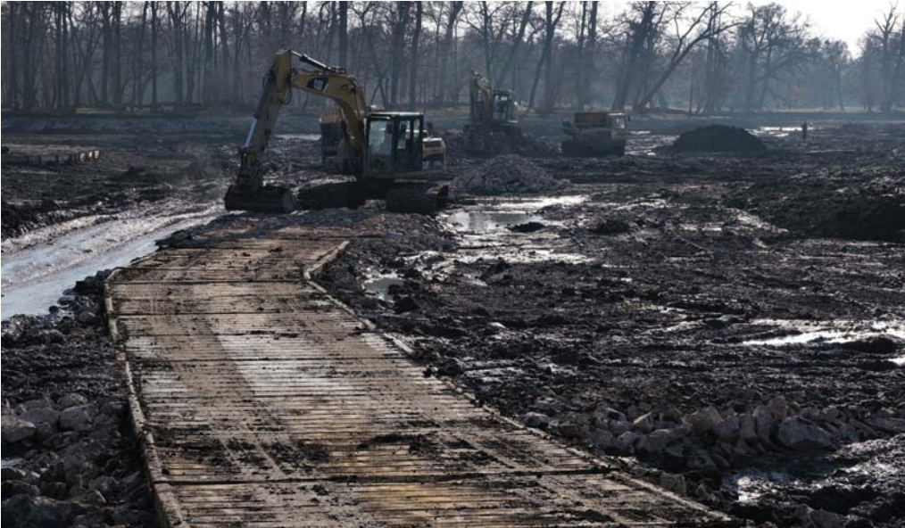
Ochrana a zpevnění břehů pomocí kovových panelů umožňující vjezd těžké techniky. Foto Oto Bernad
