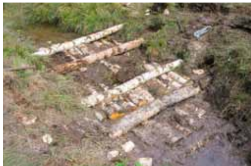
Masivní stupňovitě „skluzy“ použité na hlavním příkopu u ryb. Olšový použitý na hlavní vodoteči pro překonání většího spádu z obavy před vymíláním rašeliny. Fungují skvěle. Foto: F. Lysák, 2010
