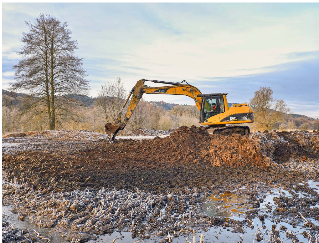
Hloubení největší tůně bagrem (v pozadí zřícenina hradu Valdštejn). Foto Vojtěch Šťastný
