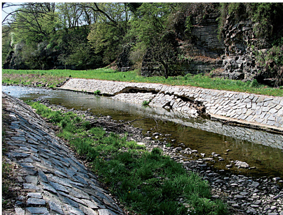
Úsek Litavky u Rejkovic byl po povodni roku 2002 vcelku nesmyslně vydlážděn. Příroda s tím není spokojena, dlažba se rozpadá. (Následně byla příčinlivým správcem toku znovu opravena.)
