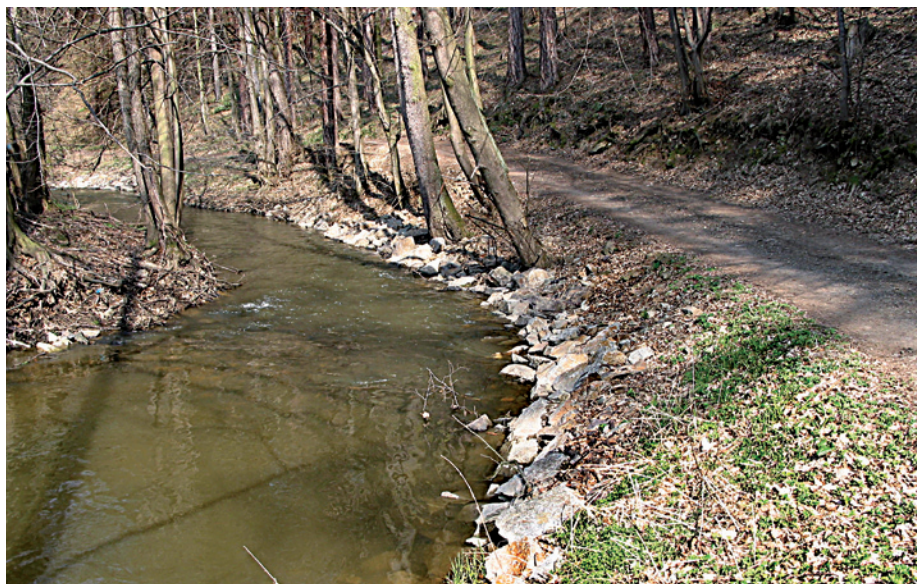
Přiměřený zásah správce vodního toku. Břehová nátrž ohrožovala užívanou místní cestu a správce provedl v ohrožené partii kamenný zához břehu.
