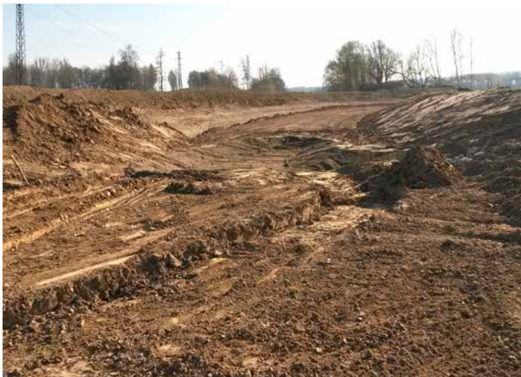
Revitalizace Jizery – realizace povodňového koryta. Foto archiv Vodohospodářský rozvoj a výstavba a.s.
