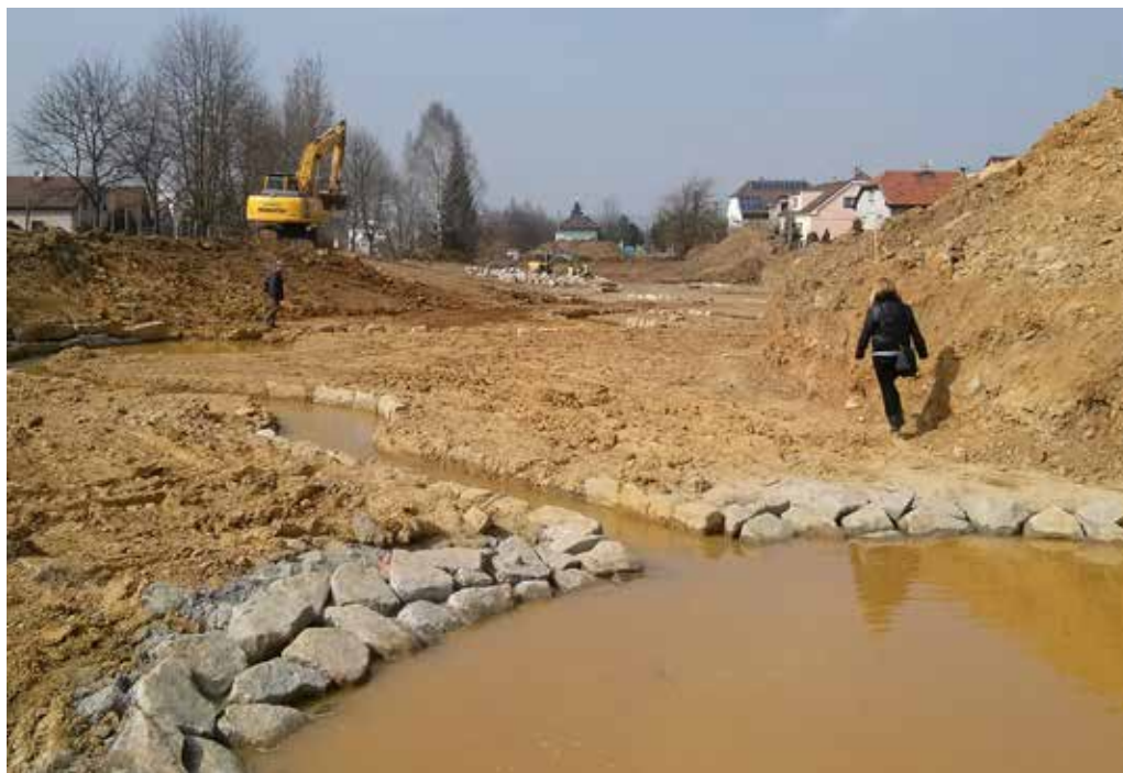
Rakovský potok – realizace povodňového koryta. Foto archiv Vodohospodářský rozvoj a výstavba a.s.
