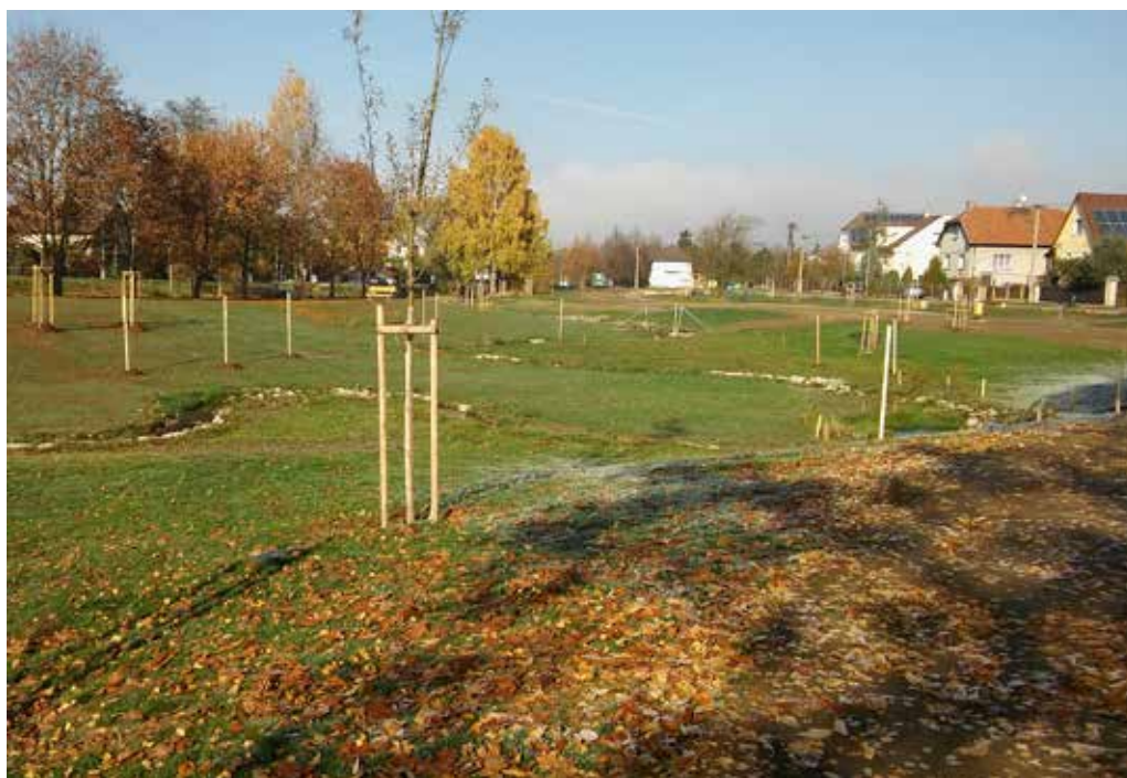
Rakovský potok – nové složené koryto. Foto archiv Vodohospodářský rozvoj a výstavba a.s.
