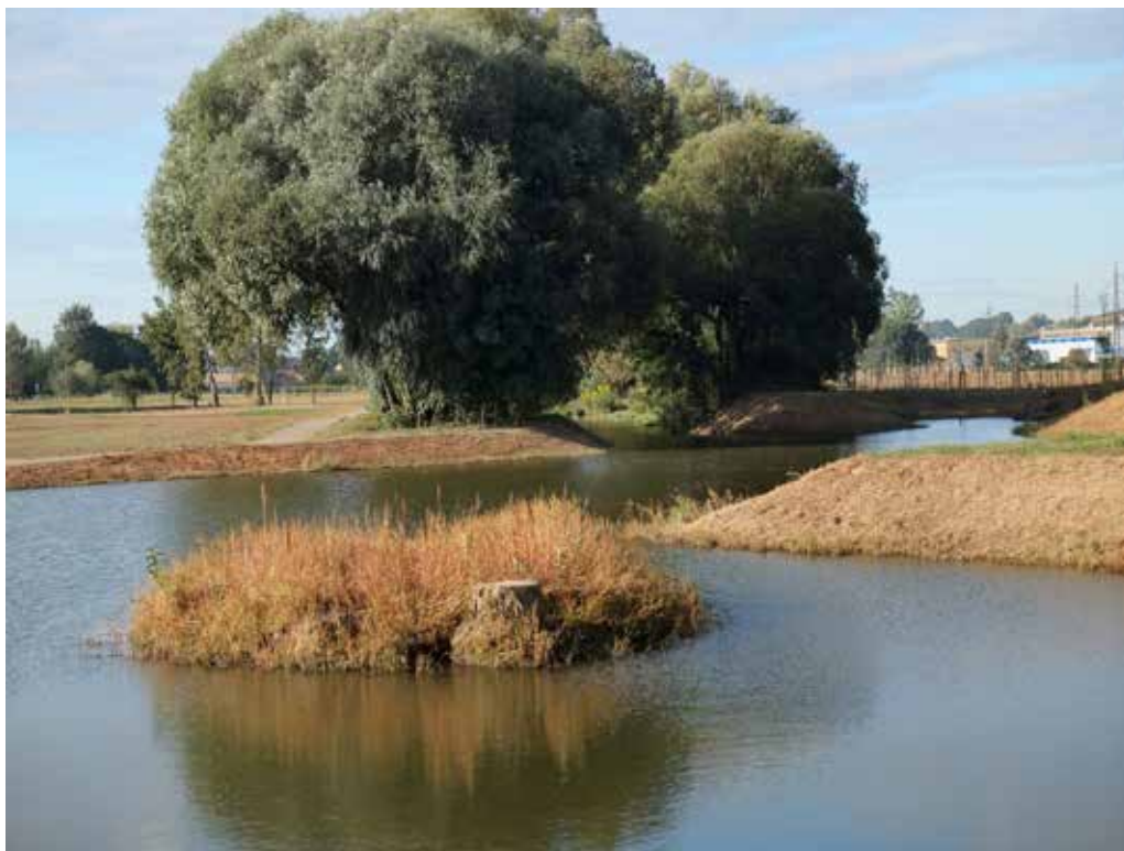
Revitalizace Jizery – horní tůň. Foto archiv Vodohospodářský rozvoj a výstavba a.s.
