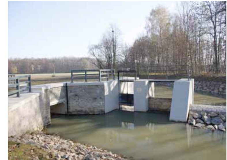
Na rozdělovacím objektu se dělí průtoky do obou větví Bílovky
