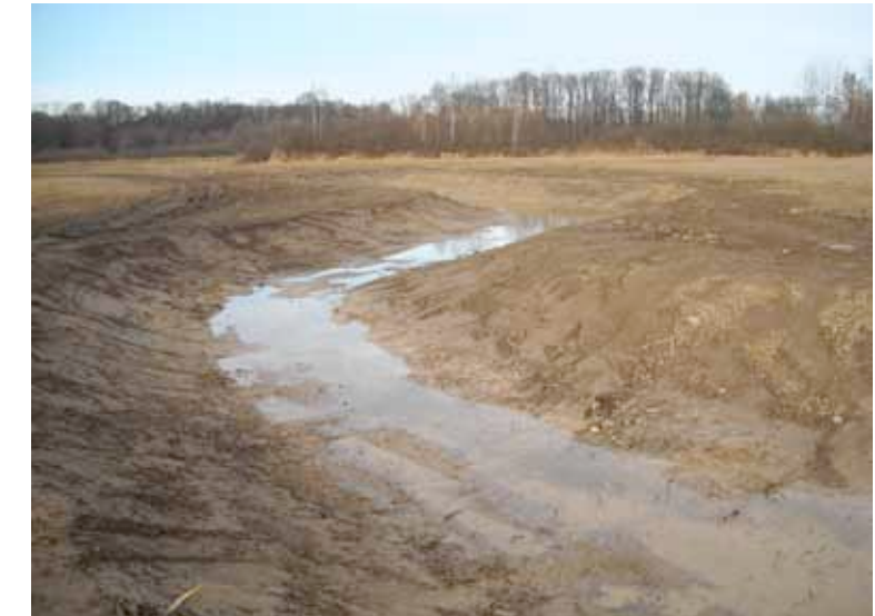
Záběr na koryto v průběhu prací
