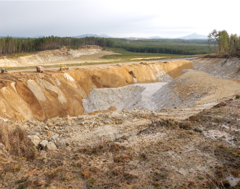
Zavážení pískovny v rámci rekultivace. Foto Slavomír Valda
