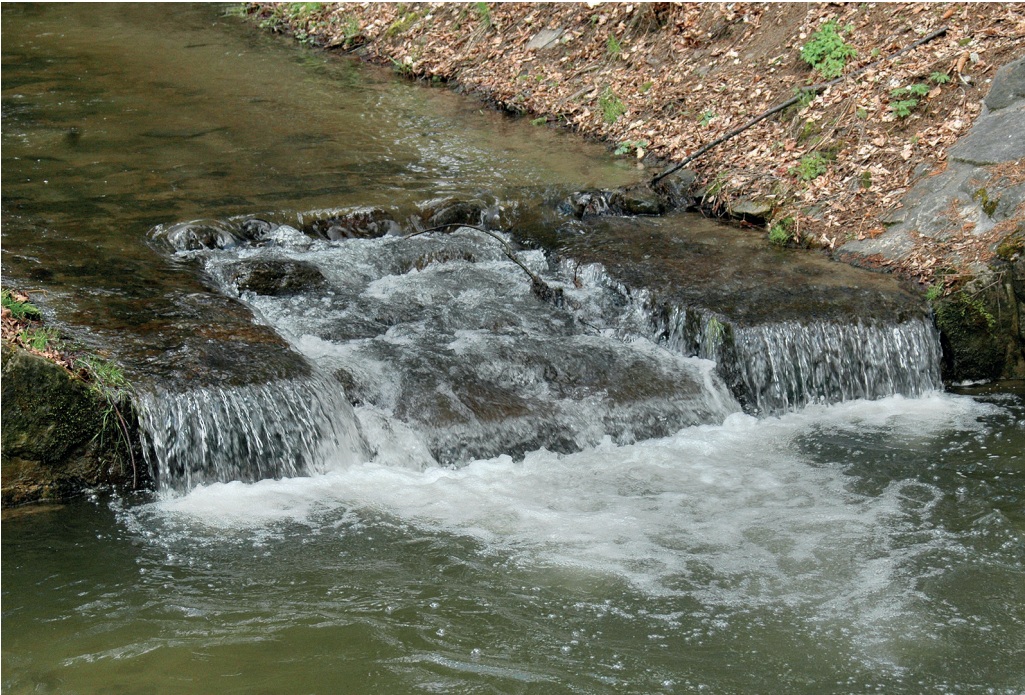
Nesprávné zprůchodnění stupně pro mihuli ukrajinskou na Račím potoce. V podjezí s hloubkou 1 m se vyskytují větší pstruzi obecní a mihule nejsou s to překonat převýšení vodního skoku. Foto Lubomír Hanel
