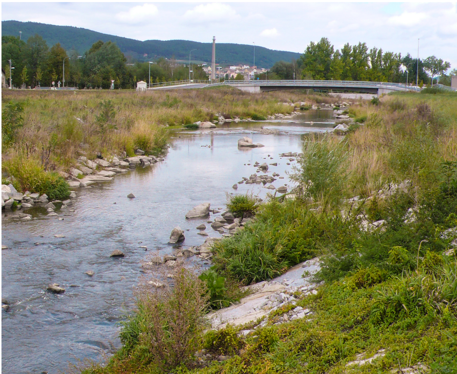
Protipovodňová úprava Litavky v intravilánu Králova Dvora, která zajišťuje velkou průtočnou kapacitu a zároveň zachovává částečně přirozený charakter koryta. Foto Tomáš Just
