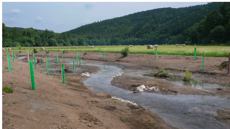
Revitalizace Loděnického potoka nad Nenačovicemi. Revitalizační stavba rámcově dobrá, ale poznamenaná neochotou ustoupit od nepřirozeně velké průtočné kapacity dřívějšího koryta, technicky upraveného. Foto Tomáš Just
