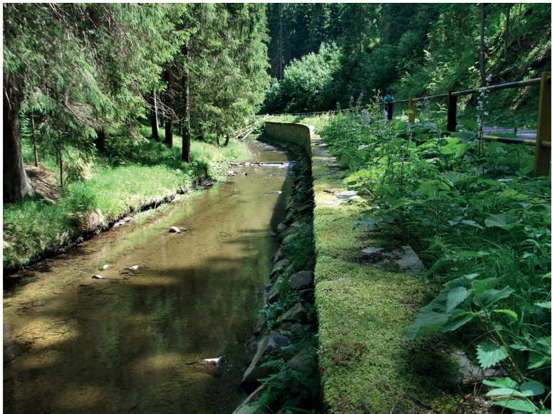
Podoba koryta Černé Ostravice v úsecích přirozené nivy (vlevo) a v úsecích s vodohospodářskými úpravami postiženými nadměrným zahloubením (vpravo). Foto Lukáš Krejčí
