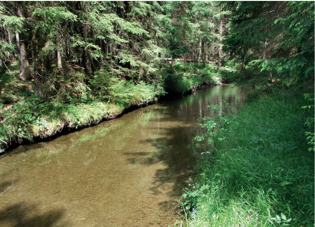
Historicky upravené koryto Černé Ostravice v úseku okolo ř. km 3,350. Napřímením a vyrovnaním sklonu spádovými stupni došlo k morfologické a hydraulické unifikaci. Patrné je též výrazné zahloubení koryta pod okolní nivou a zánik typických příbřežních stanovišť. Vhodným opatřením je umístění diverzifikačních prvků do koryta a podpora korytotvorných procesů. Foto Lukáš Krejčí
