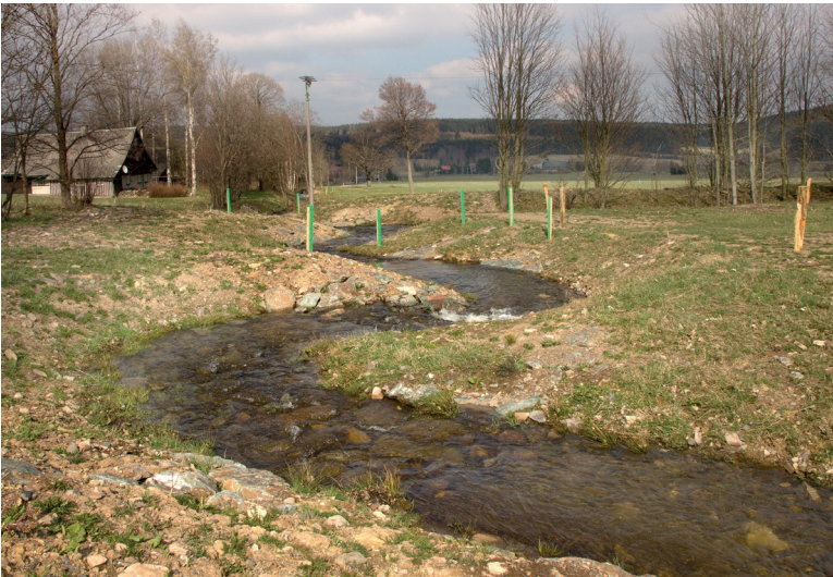
Revitalizace vodního toku. Foto Zuzana Růžicková
