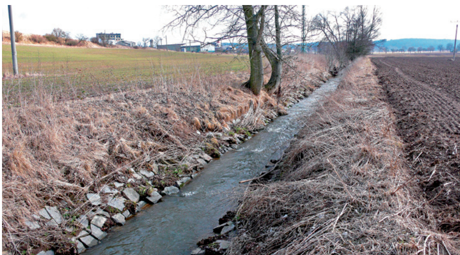
Koryto technicky upraveného potoka je napřímené, výrazně zahloubené, má nepřírozeně velkou průtočnou kapacitu. Kyneta je opevněna zjevně odolnou dlažbou. Pro zlepšení morfologického stavu tohoto úseku je potřebná revitalizace – kategorie A.
