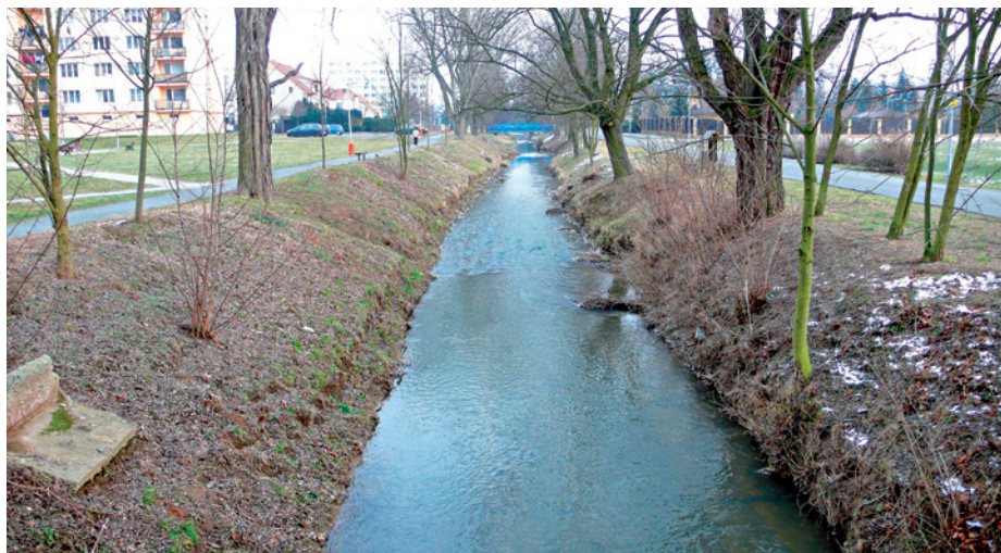
Technicky upravený vodní tok v zastavěném území. Koryto je velmi vzdálené přírodě, morfologicko-ekologický stav nevyhovující, přesto není okolní zástavba dostatečně chráněna před povodněmi. Navrhujeme zařazení do kategorie C – přírodě blízké rozvolnění v travnaté, přestože provedení nebude vzhledem k omezenému prostoru jednoduché.
