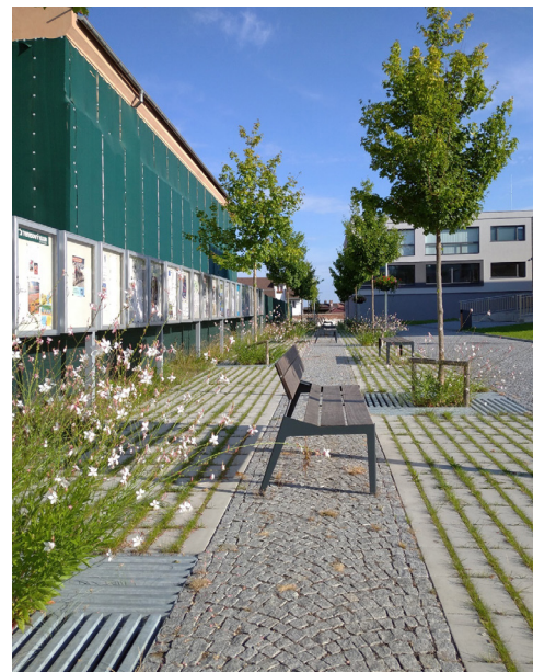
Občasné pocházené plochy jsou vytvořené ze zatravněných dlažeb, které napomáhají zadržení srážkové vody v lokalitě a snižují povrchový odtok. Foto Libor Sedláček
