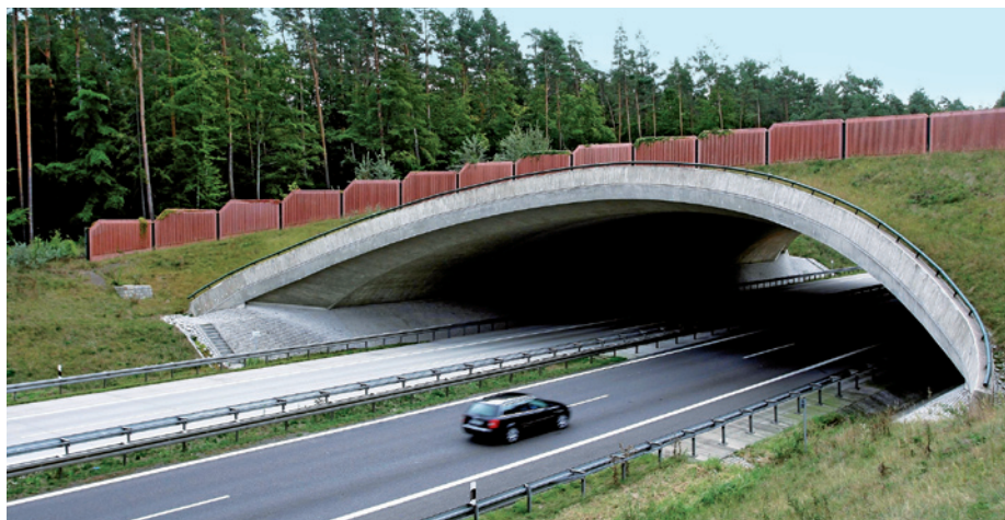
V území, kde dálnice rozděluje cenná přírodní stanoviště nebo kříží důležité migrační cesty, lze její bariérový účinek eliminovat stavbou ekoduktu. Oproti podchodům pod dálnicí není u tohoto řešení rozvoj vegetace limitován světelným a srážkovým stínem, a může tak dojít k plnému propojení biotopů na obou stranách dálnice. Foto Václav Hlaváč
