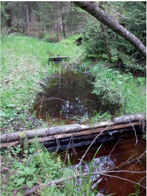
Eliminace odvodňovacích rýh v nivě Černé Ostravice. Srubové přehrážky mají za cíl zabránit vysušování nivních stanovišť. Foto František Šulgan
