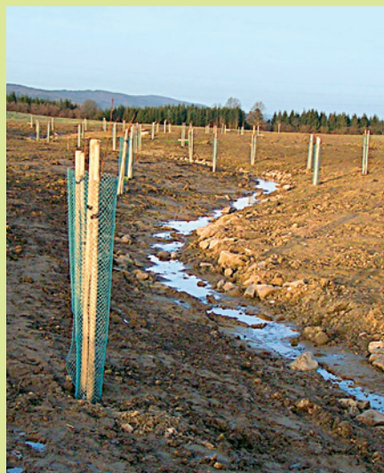
Revitalizovaný úsek vodního toku nad vodní nádrží po dokončení
