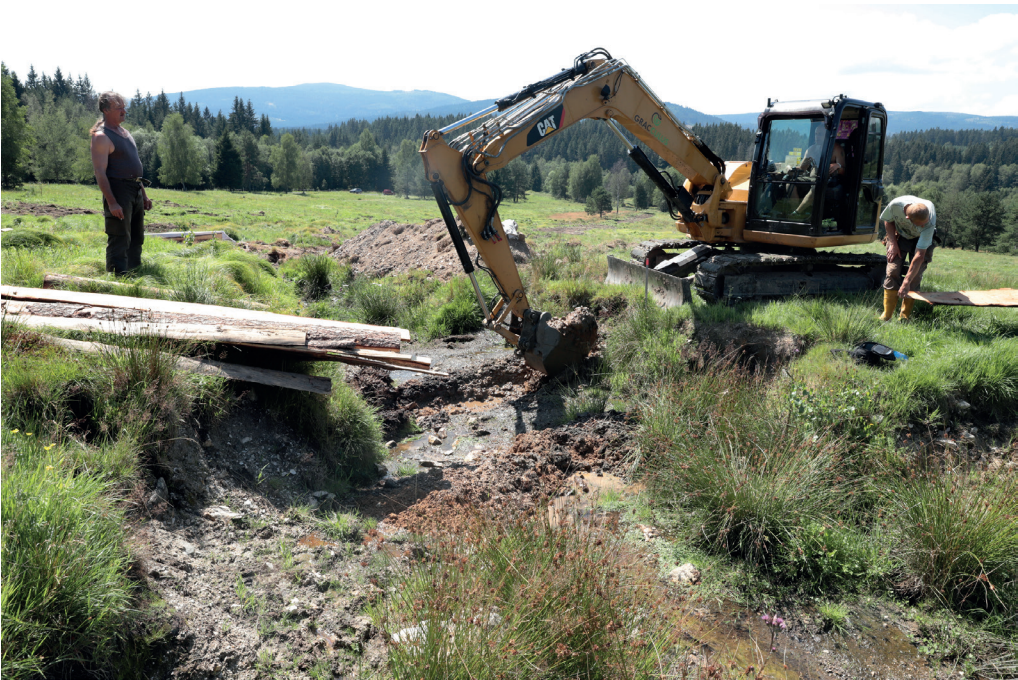
Zablokování odvodňovacích rýh na lučním prameništi (Malý Bor, LIFE). Foto Iva Bufková
