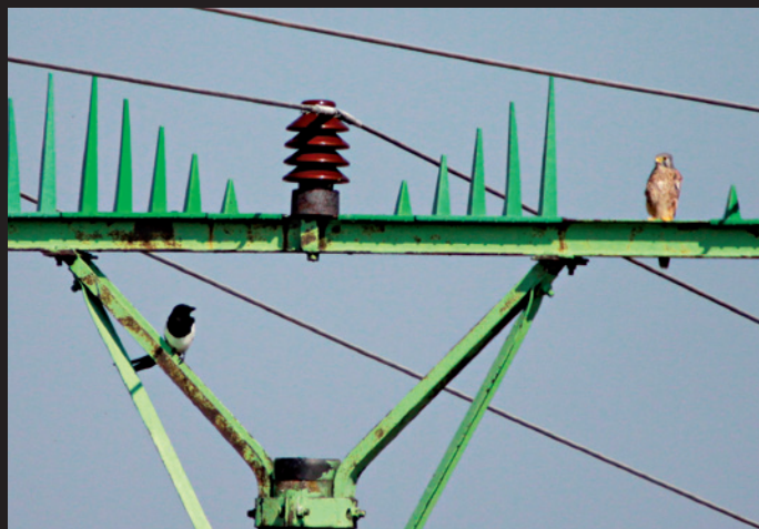
Obř. 5 Hřebeny s vylomenými hroty nutí ptáky usednout do blízkosti izolátoru a představují tak pro ně velké riziko.
