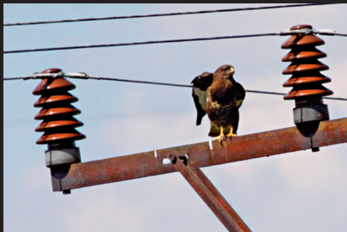
Obr. 3 Káně lesní sedící na rovinné konzole, na níž je zaznamenaná vysoká frekvence úrazů.
