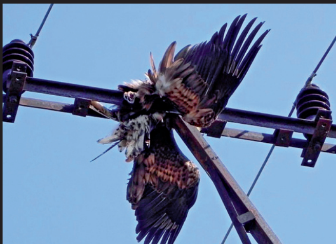
Obr. 2 Orel mořský usmrcený elektrickým výbojem při dosednutí na sloup s rovinnou konzolou Foto Vlasta Škorpiková
