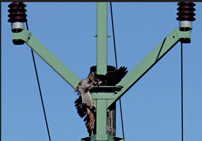
Obř. 4 Káně lesní usmrcené elektrickým výbojem na konzole typu Pařát. Na tento typ konstrukce ptáci sedají jen výjimečně, ale zároveň riziko úrazu při dosednutí je vysoké.
