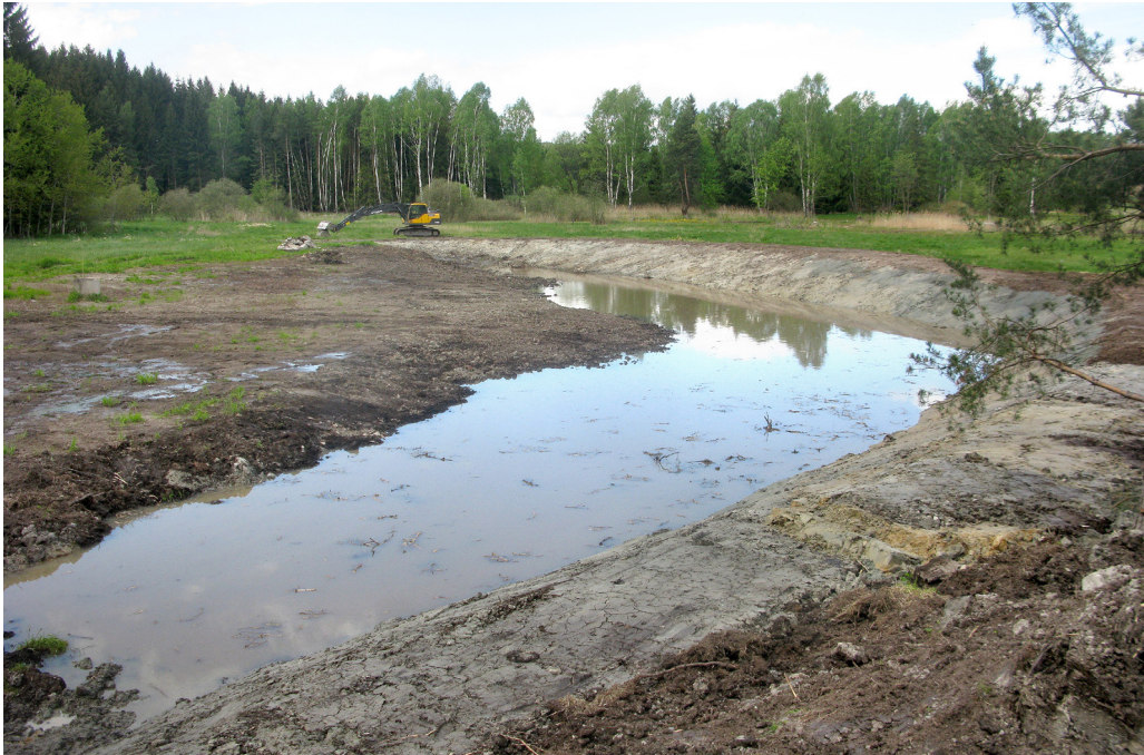
Voda zaplavuje nejdříve jámu po těžbě materiálu na hráz. Litorální zónu bude tvořit přirozený terén vlevo (proběhlo zahrnování příkopů). Foto Filip Lysák
