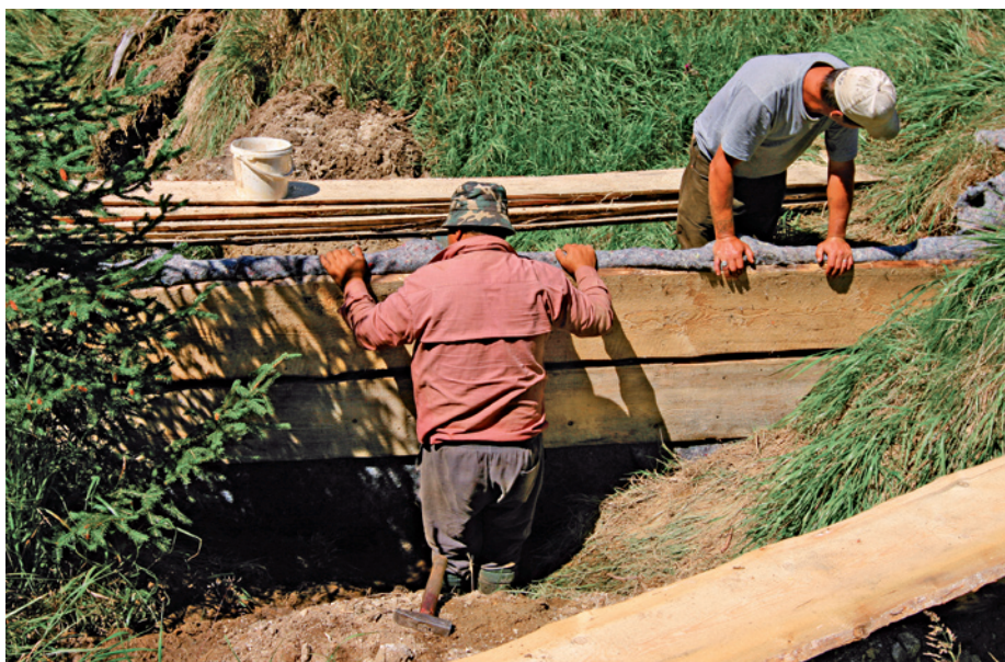
Obrázek 2a Všechna revitalizační opatření jsou prováděna ručně, včetně zablokování kanálů dřevěnými hrázemi. (Nad rybárnou, 2008)
