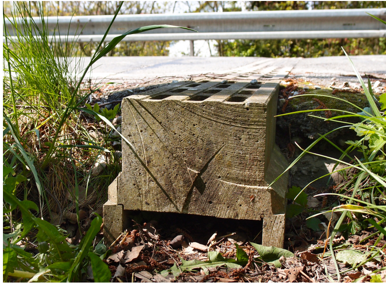
Obr. 6, 7 Torza dřevěných naváděcích zábran s notně zaneseným podchodem pro obojživelníky v Trnávce na Novojičínsku. Foto Petr Vlček
