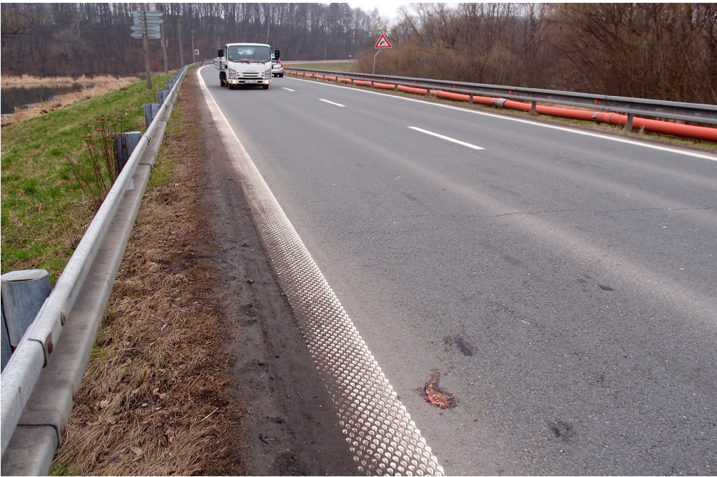
Obr. 2 Mortalita skokanů hnědých na zábranami chráněném silničním úseku komunikace I/11 v Těrlicku. Foto Petr Vlček
