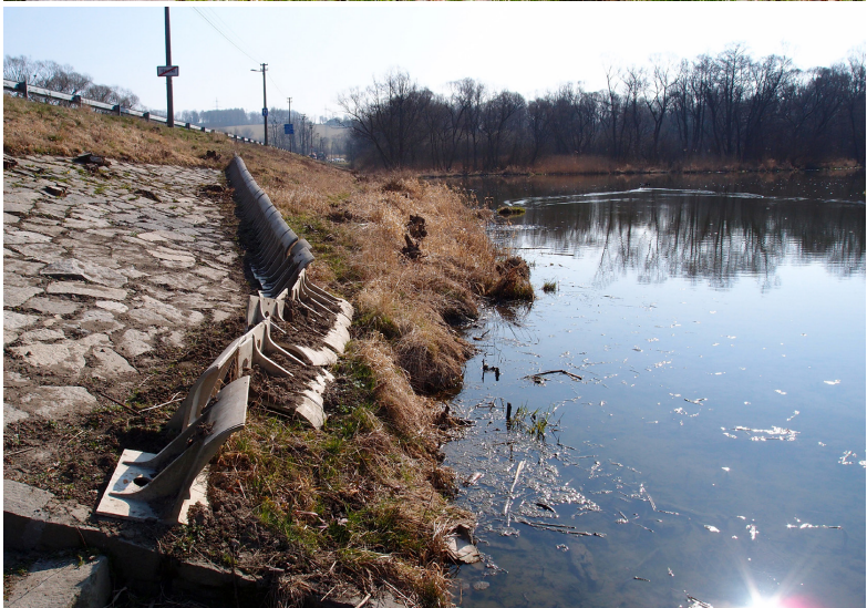
Obr. 4 Některé z příkladů nevyhovujícího stavu těrlických naváděcích zábran. Foto Petr Vlček
