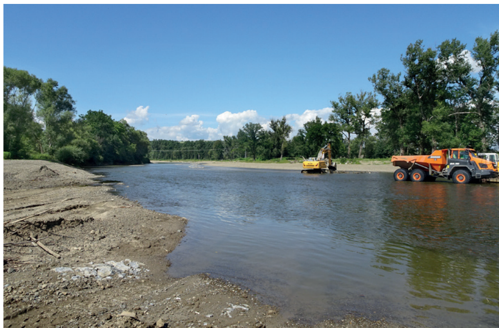
Obr. 4 Revitalizace Bečvy u Černotína a Skaličky v celkové délce více než 3 km, zásadní rozšíření koryta a vytvoření nové aktivní nivy. Foto Kateřina Kujanová
