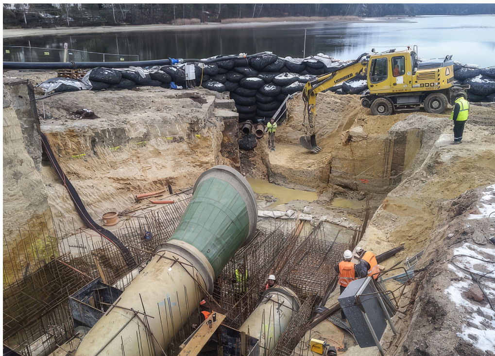
Obr 3: Významnou část ze státních pozemků svěřených AOPK ČR tvoří rybníky (3 746,1 ha), ta je tak druhým největším správcem rybníků v ČR. Na fotografii generální oprava výpusti Máchova jezera realizovaná AOPK ČR. Foto Pavel Trnka
