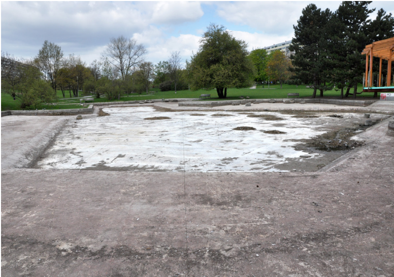
Obr. 3: Pohled na nádrž po vysušení a shrabání kalu (následně deponováno) a ošetření spár chlorovým vápnem (polovina dubna 2017). Foto Tomáš Görner
