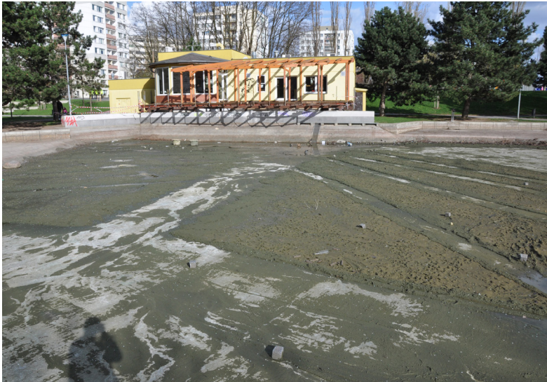
Obr. 2: Vodní nádrž v parku Přátelství těsně po úplném vypuštění vody. Pod trámovou konstrukcí u budovy se nachází výpustní šachta. Konec března 2017. Foto Tomáš Görner
