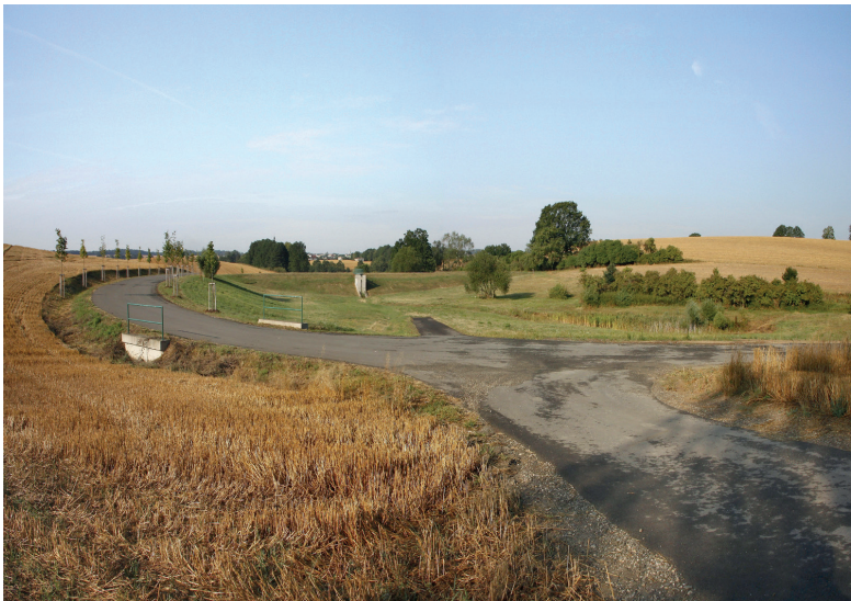
Poldr u obce Hať na Opavsku – součást systému vodohospodářských a protierozních opatření. Foto Radim Jarošek
