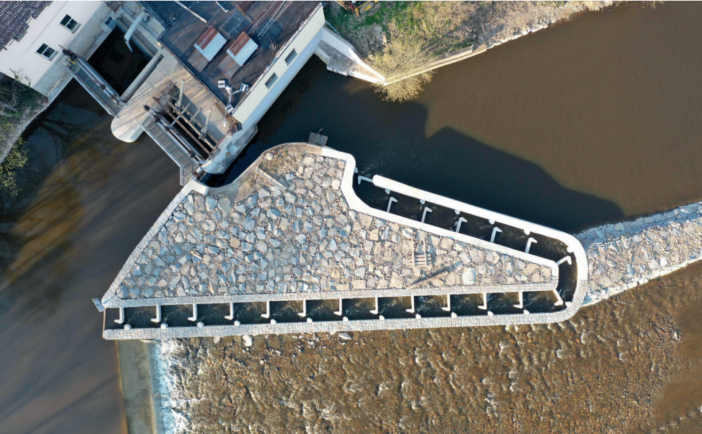
Letecký pohled na štěrbinový rybí přechod a objekty malé vodní elektrárny v Řevnicích – levý břeh. Foto archiv Povodí Vltavy, s. p.
