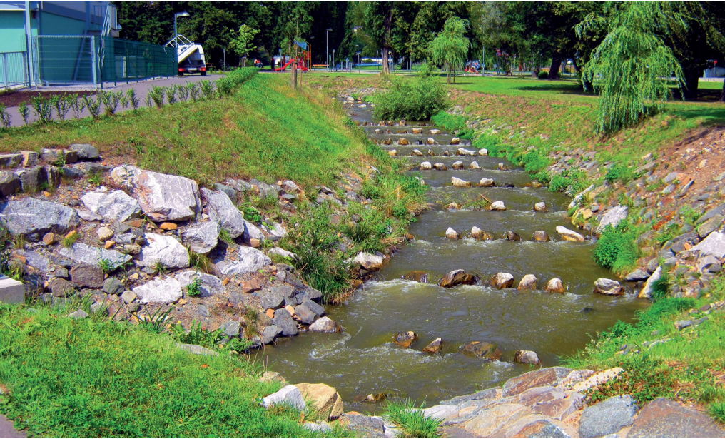
Rybí přechod v Berouně. Mezi již postavenými rybími přechody na Berounce pod Křivoklátem je doposud jediným, u kterého bylo provedeno biologické hodnocení. Dle výsledků se jedná o funkční rybí přechod. Foto Zdeněk Vogl
