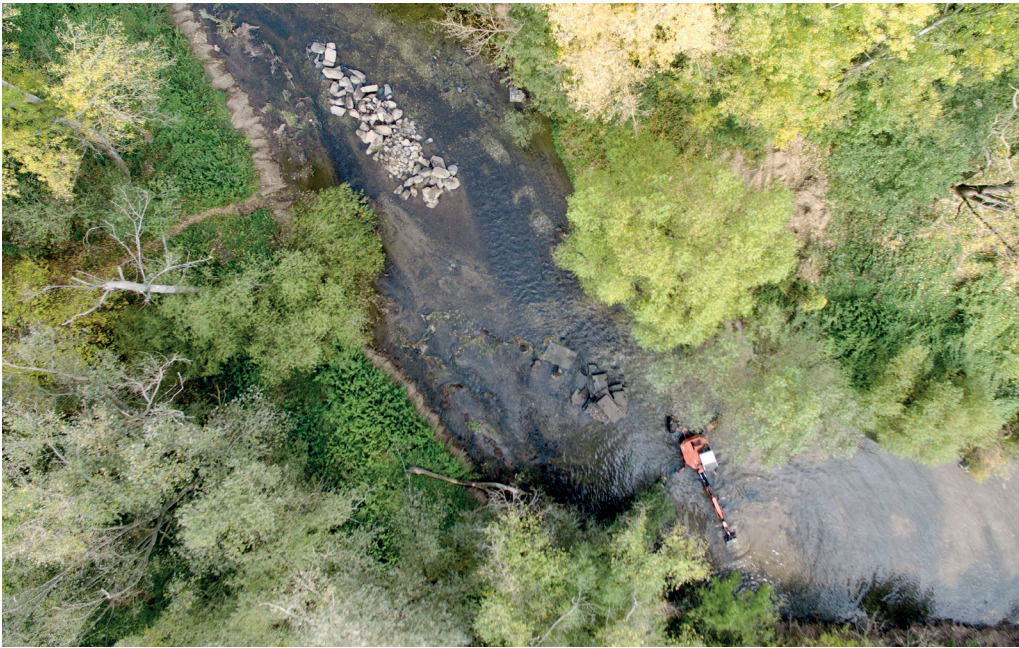
Odstraňování opevnění břehů. Foto Petr Zifčák
