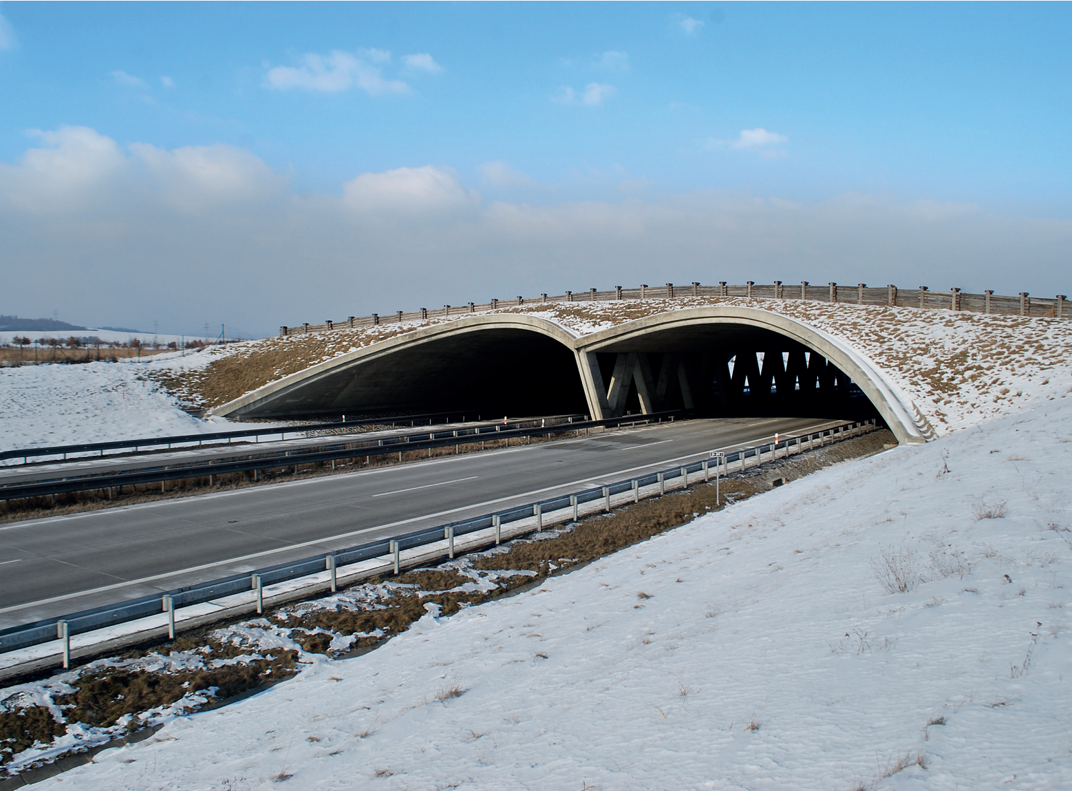
Speciální nadchod (ekodukt) u Suchdola nad Odrou – místní části Kletné – byl postaven v otevřené zemědělské krajině bez přidání naváděcí zeleně. Foto Martin Strnad
