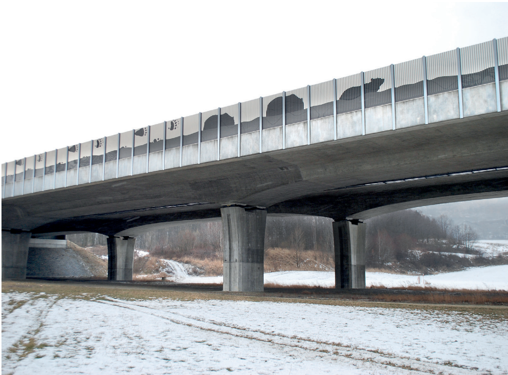
Estakáda zaručuje volný průchod pod komunikací všem skupinám živočichů. Důležitý je však typ podmostí, který musí být co nejpřirozenější (štěrk nebo asfalt není vhodný). Foto Martin Strnad
