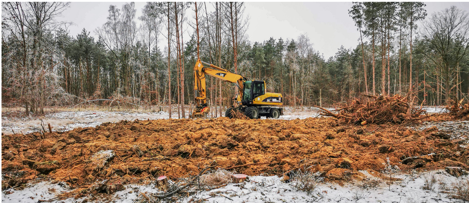
Odstranění akátových kořenů pomocí sklízecích hrábí. Foto Kai Heinemann
