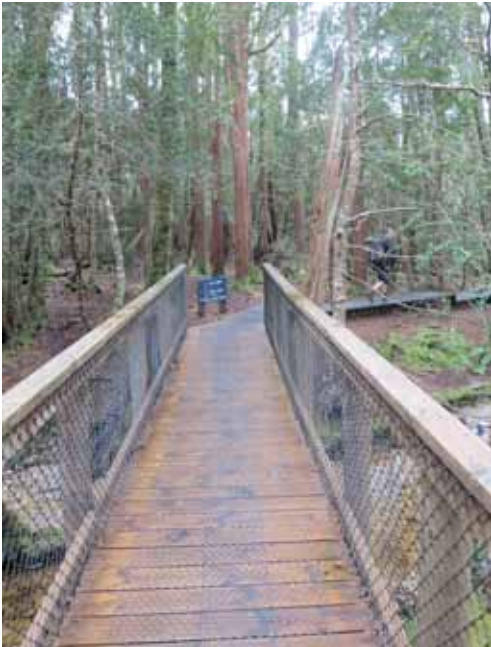
Tasmánii protíná celkem 2 000 km značených stezek. Značná část z nich je dřevěná, vyztužená drátěnou sítí. Foto: Jan Plesník
