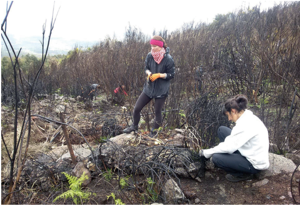
Management: Instalace sítě s kameny na svažitém pozemku organizace Montis. Překážka má zabránit odnosu vzácně získané půdy vodou, která prudce stéká ze svahu. Foto Martina Kišelová
