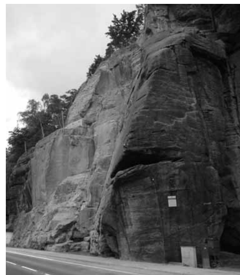
Dokončená sanace Lomové stěny. Ize vidět kotvený železobetonový práh a dynamickou bariéru.
