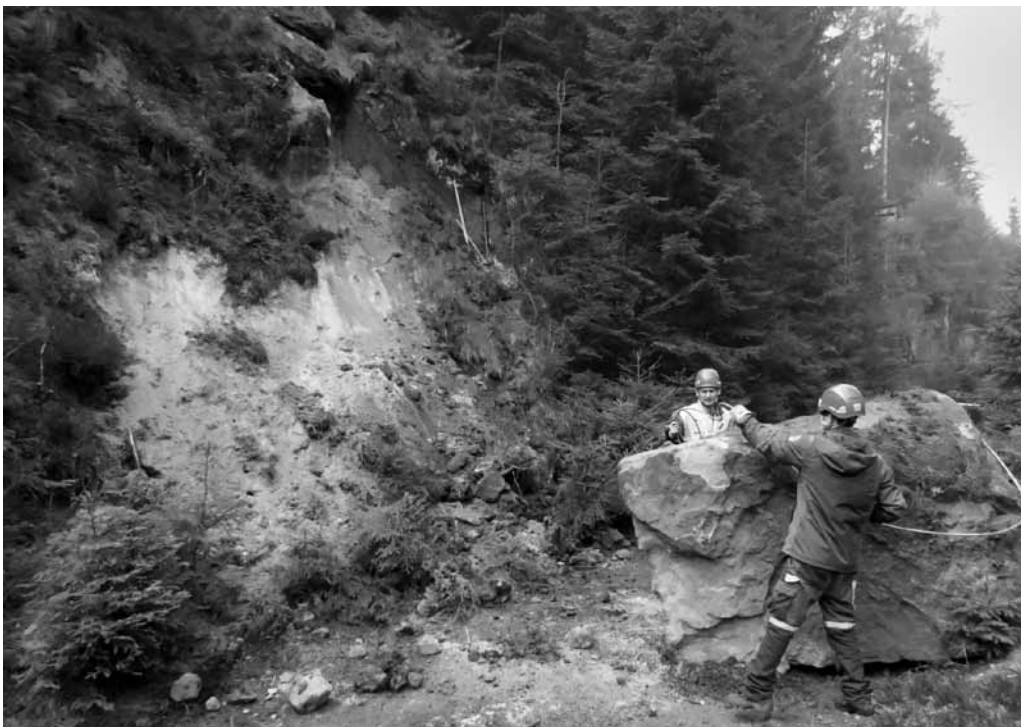
Řízený shoz balvanu v Kyjovském údolí o hmotnosti přibližně 10 tun – blok byl natolik nestabilní, že jej bylo možno svrhnout bez použití techniky, pouze ručně.
