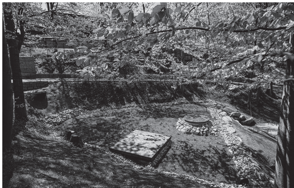
Pohled na nově vytvořený mokřad s vertikálním kořenovým filtrem, jehož struktura a vegetace nejenže esteticky obohacují okolí, ale také snižují teplotu v blízké zástavbě a zároveň přirozeně filtrují znečištění. Foto Radek Petrášek
