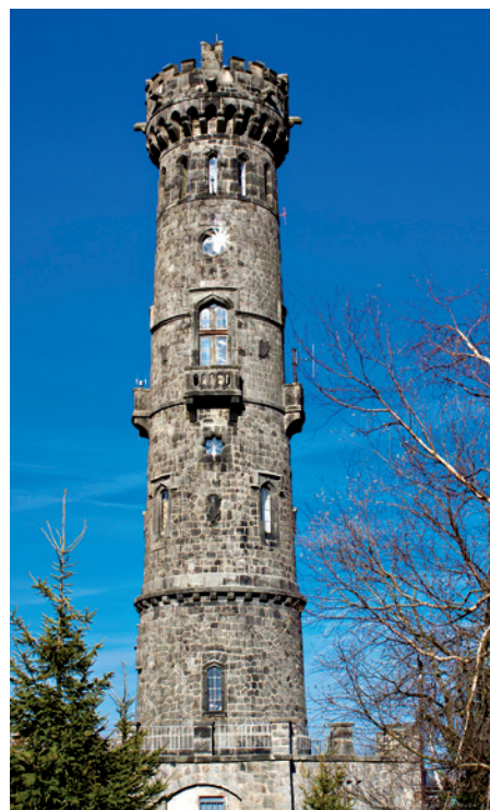
Originální stavba, připomínající šachovou figuru, byla na vrcholu Vysokého Sněžníku postavena v roce 1864.
