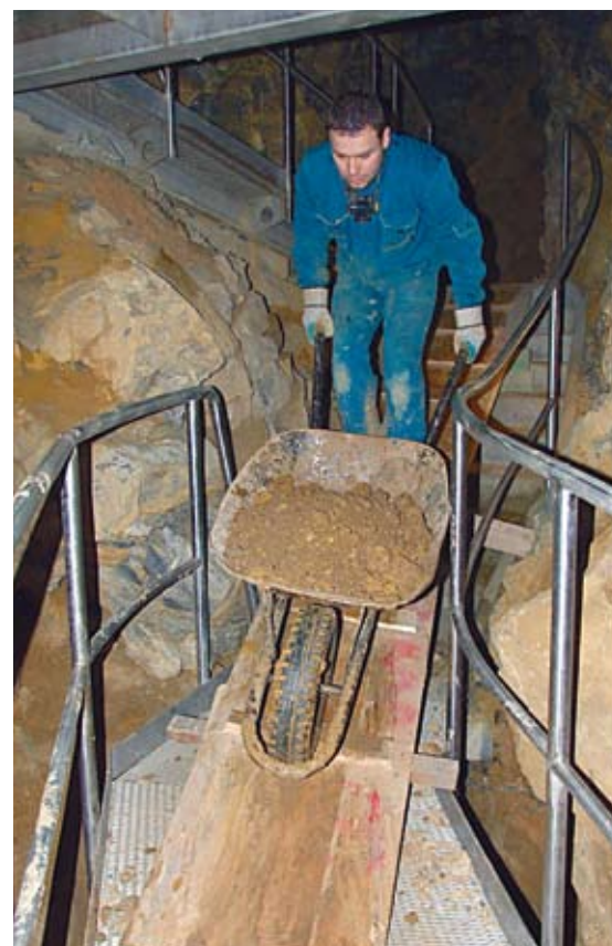
Transport koleček směrem k východu po bednění na schodištích Foto S. Černý
