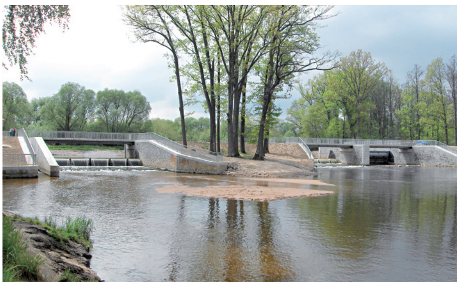
Tři nové klapkové jezy na Novořeckých splavech (Rozvodí) umožňují přesnější regulaci průtoku Lužnice mezi Starou a Novou řekou. Tradiční Krčinův princip tak získal moderní tvář. Při levém okraji je vidět šterbinový rybí přechod. Území je součástí nově vyhlášené NPR Stará a Nová řeka.
