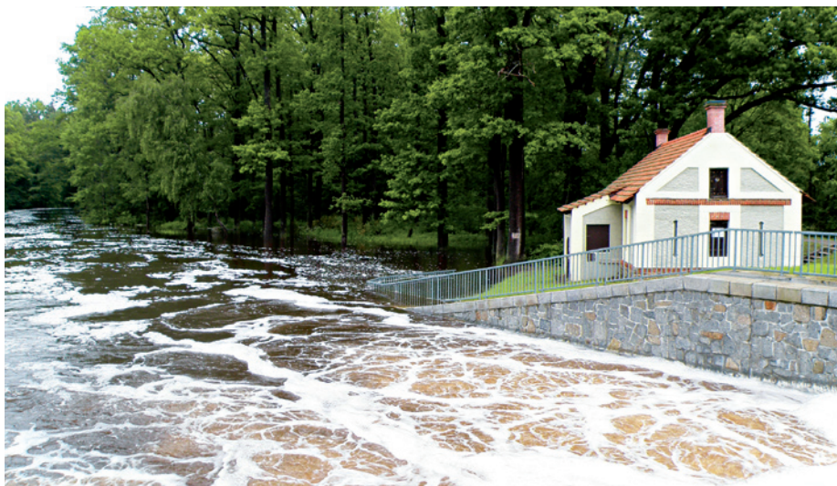
Nové jezy na Novořeckých splavech (Rozvodí) převádí vodu do Staré řeky v průběhu červnové povodně 2013. Průtok je na úrovni mezi desetiletou a dvacetiletou vodou a v prostoru říční nivy nepůsobí řeka žádné škody.
