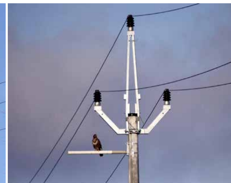
Jedním sloupem s nulovou mortalitou je typ Pařát III v přímém úseku, s bidlem umožňujícím bezpečné dosedání ptáků. Foto Václav Hlaváč
