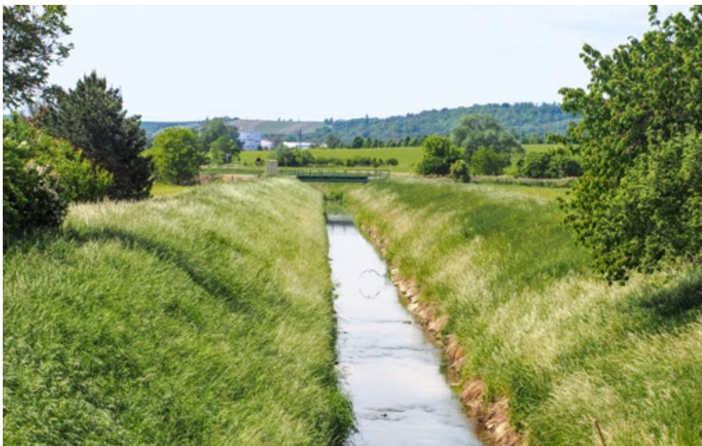
Niva s kapacitním korytem úseku vodního toku mimo sídlo. Kapacitní koryto vodního toku Litava mimo sídlo ve Slavkově u Brna s potenciálem k revitalizaci úseku vodního toku a k obnově ekologicko-stabilizačních funkcí prvku (podpora retence a přirozené akumulace povrchové vody, rozvoj přírodních biotopů). Foto Klára Pavková
