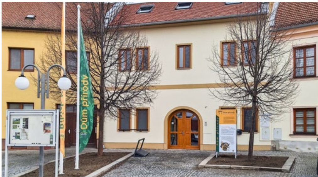
Původní budova na Bartolomějském náměstí byla zvýšena o jedno patro. Foto Jitka Říhová
