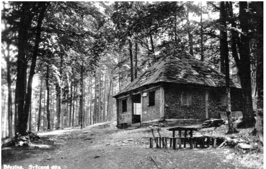
Vchod do Svěcené díry na pohlednici z roku 1939. Archiv Správy Javoříčských jeskyní.
