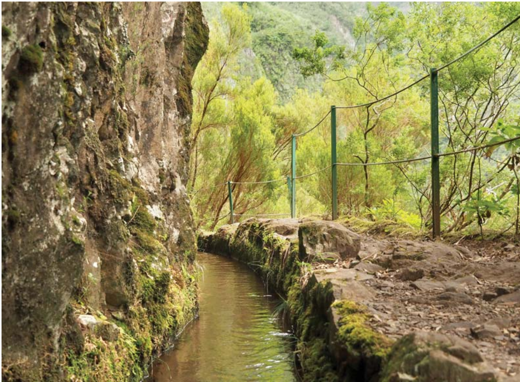
V zemi bez trvalých řek by byl život lidí prakticky nemožný bez budování umělých kanálů, tzv. levád, které vodu jímají a přivádějí z vodou bohatých návětrných stran ostrovů. Foto Miroslav Zeidler
