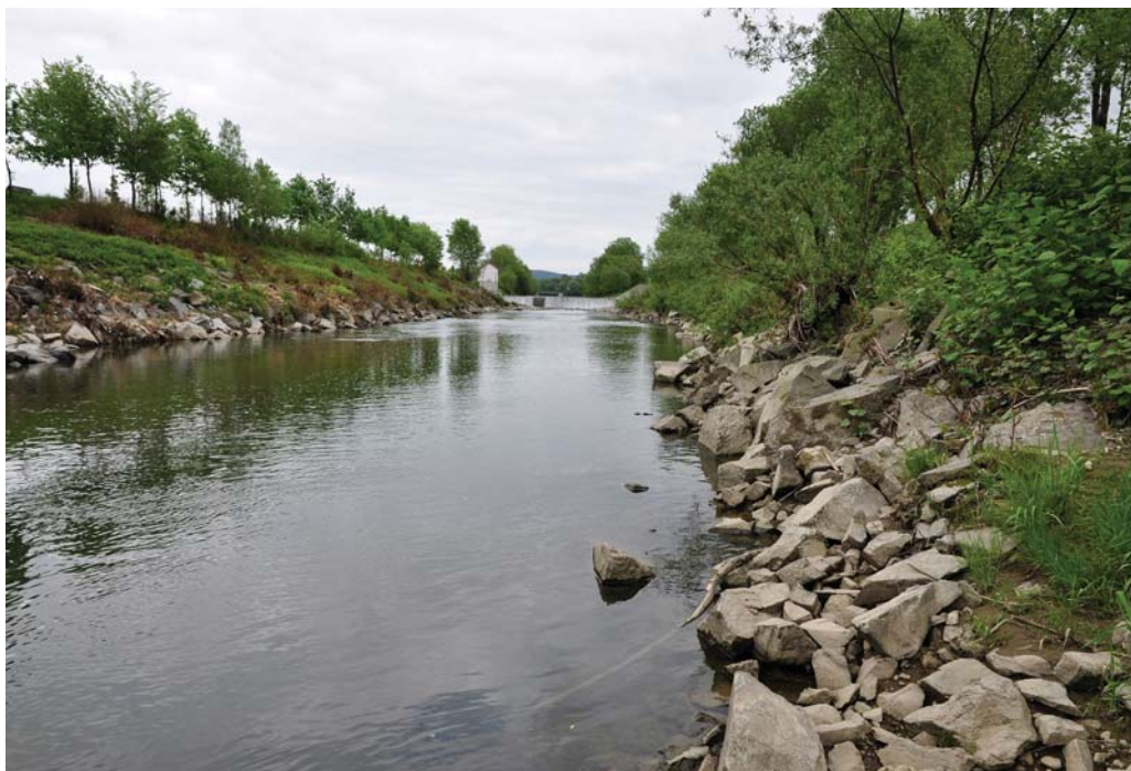
Dnešní kanalizované koryto Bečvy pod stupněm Osek. Původní šterkonosné větvení je dávno ztraceno, zůstává hluboký kanál na převádění maxima vody. Foto Michal Krejčí
