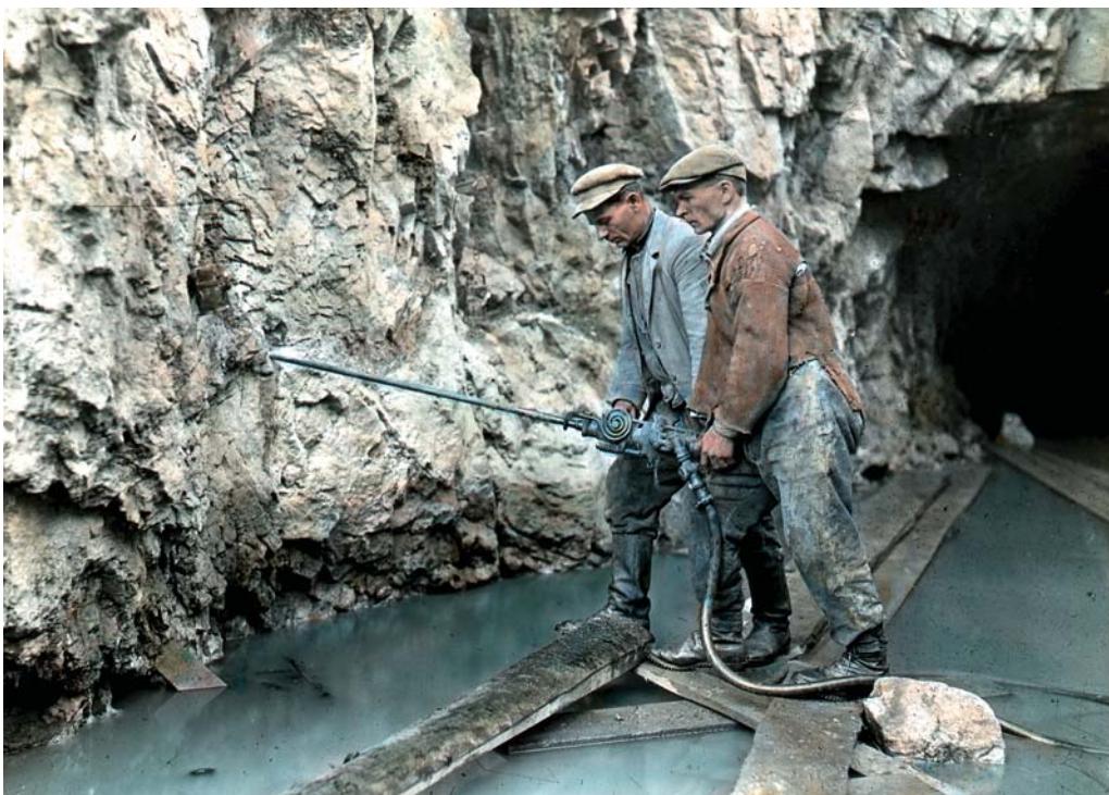
Vrtací práce na odvodňovacím tunelu. Foto K. Absolon, reprofoto Petr Zajíček
