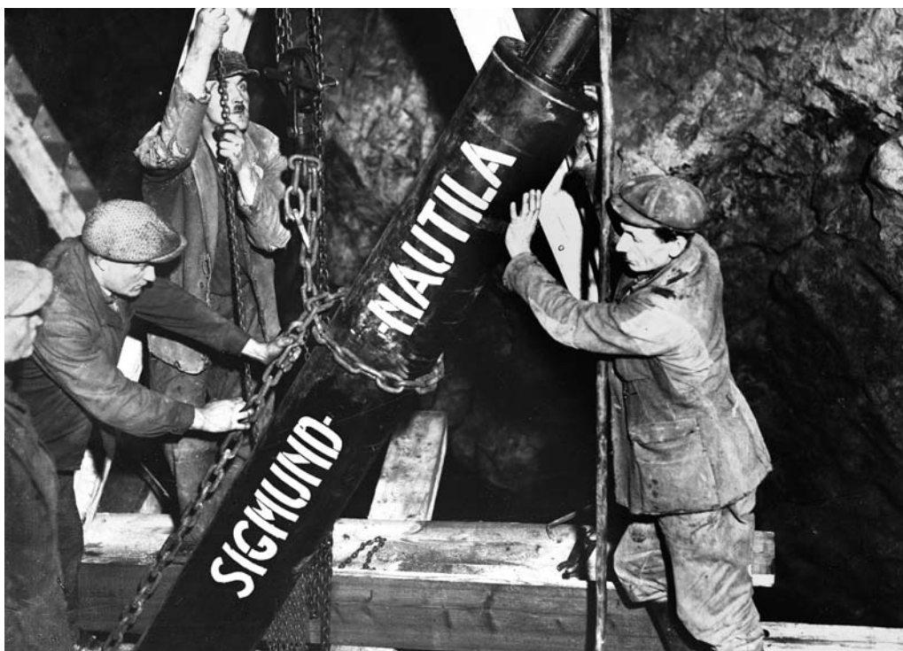
Instalace čerpadel Nautila do Zlého sifonu. Foto K. Absolon, reprofoto Petr Zajíček
