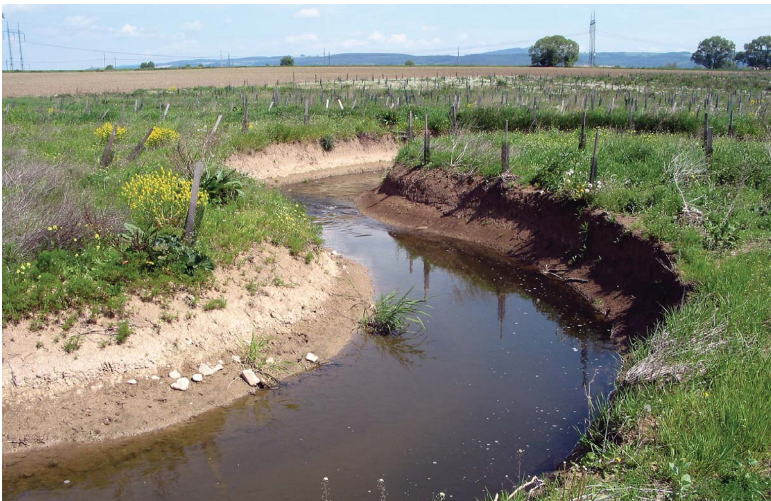
Nové koryto Lukovského potoka v zátopě protipovodňové nádrže Žichlínek, stav v květnu 2008. Revitalizační hodnotu silně omezuje neodůvodněně velké zaklesnutí vodní hladiny proti okolnímu terénu. Foto Tomáš Just
