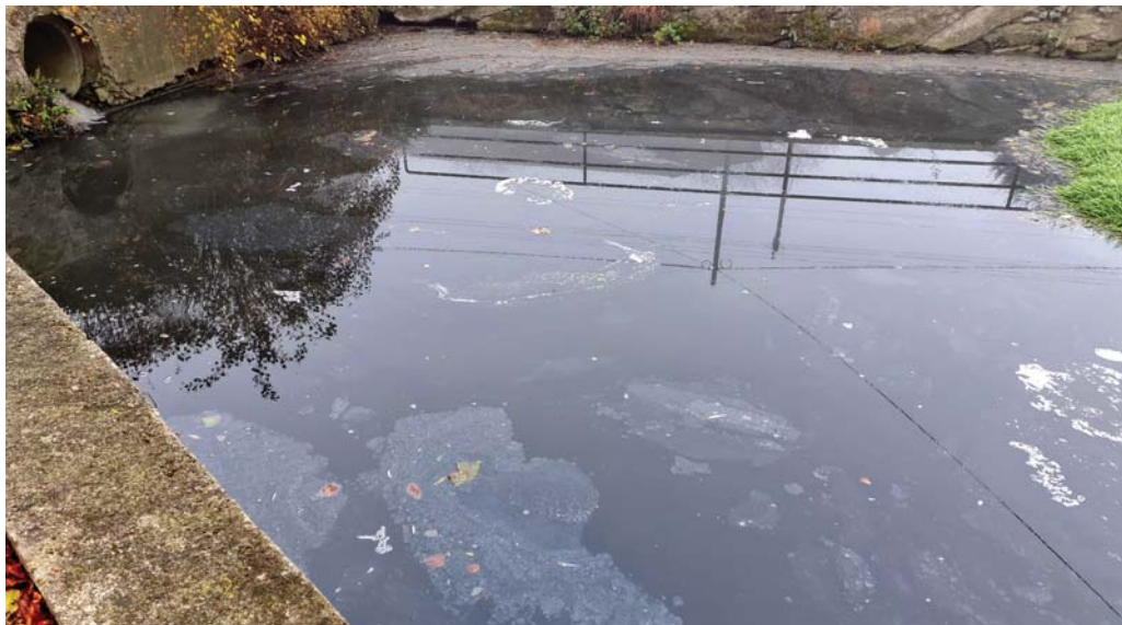
Výúst jednotné kanalizace obce Lipovec, která nemá vyřešené čištění odpadních vod a jejíž vody tečou na území CHKO Moravský kras do systému Amatérské jeskyně. Foto Jan Foller
