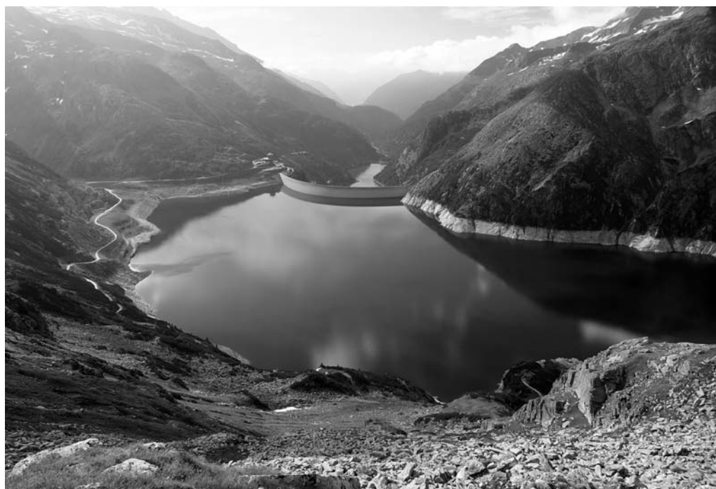
Přehrada Hauptspeicher Kölnbrein (Vysoké Taury, Rakousko). Foto Miroslav Zeidler
