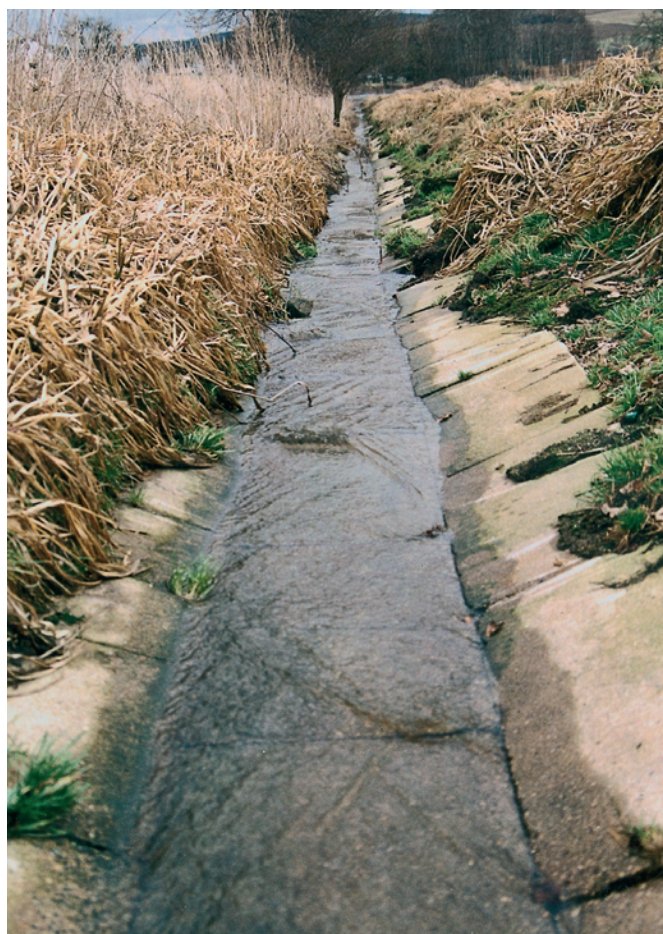
Křovice u Sedlčan – napřímený tok potůčku Lužnice opevněný betonovými tvárnicemi
