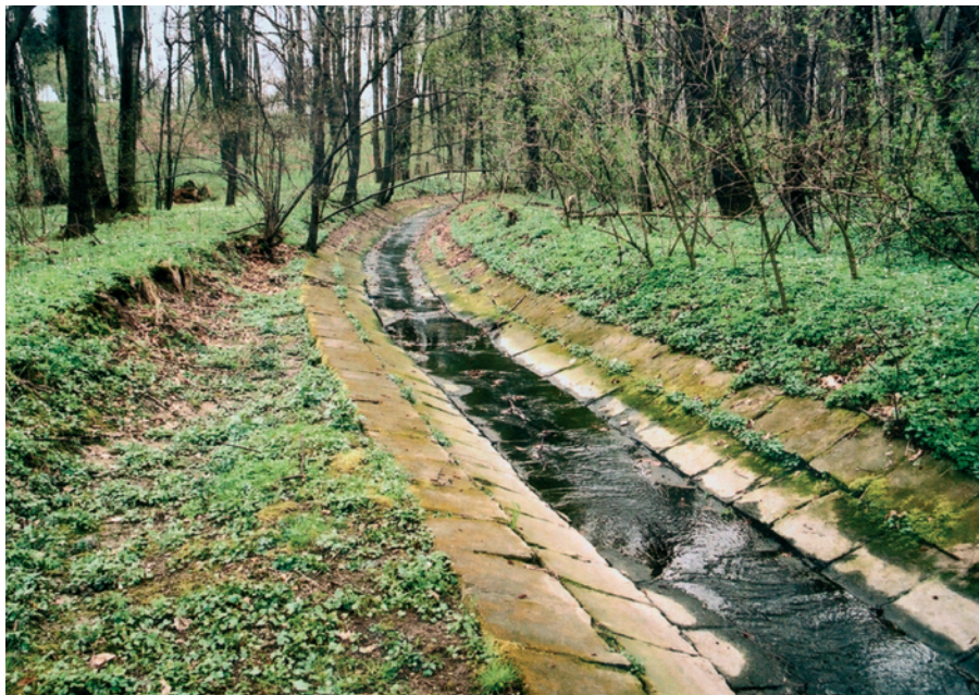
Odvodňovací kanál opevněný betonovými deskami v lužních hájích v Poodří
