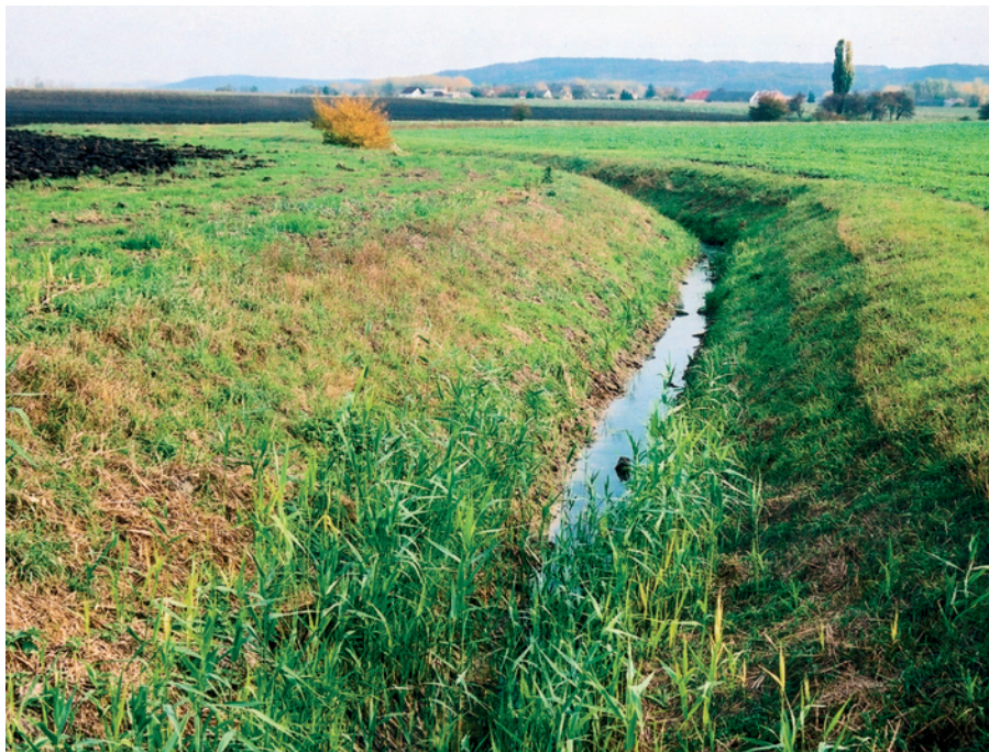
Valská svodnice představuje typickou ukázkou odvodnění niv v zemědělské krajině na křídových slínech Mladoboleslavska
