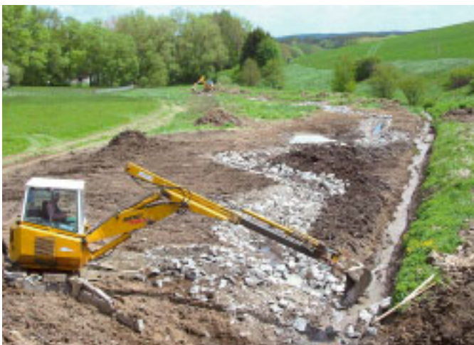
Pohled na dolní úsek revitalizace za výstavby. Přímé a hluboké původní koryto je nahrazováno novým, přírodě blízkým
