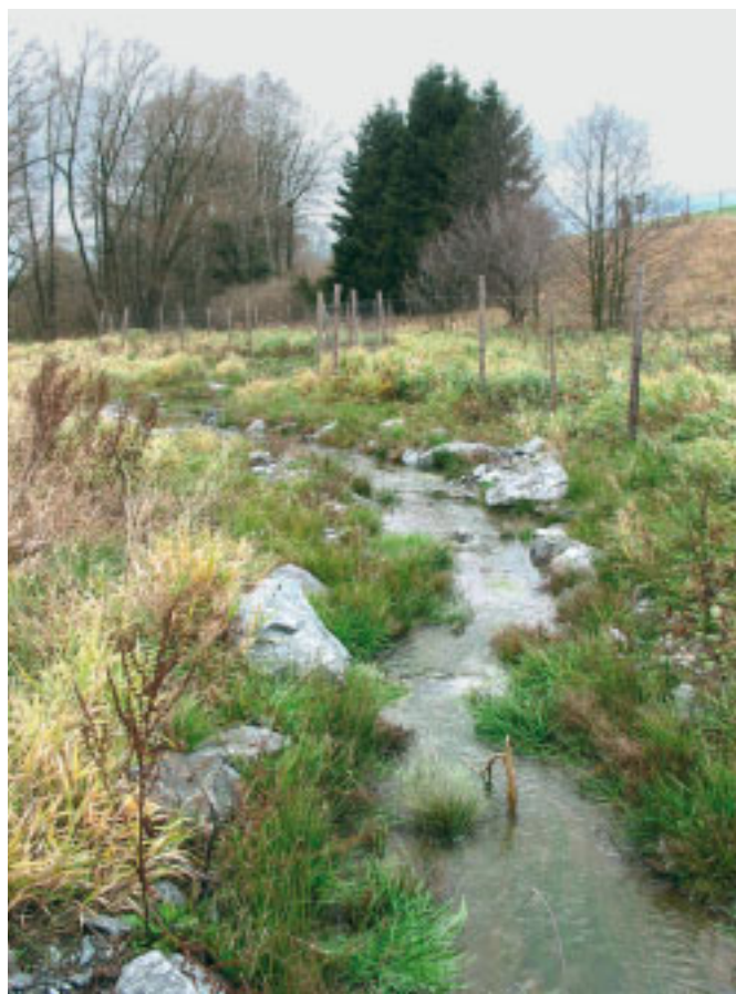
Nové koryto, dokončené v červnu 2004, na podzim téhož roku; vegetace začíná skrývat silné opevnění koryta kamenivem, které bylo položeno z obavy o stabilitu díla Foto T. Just
