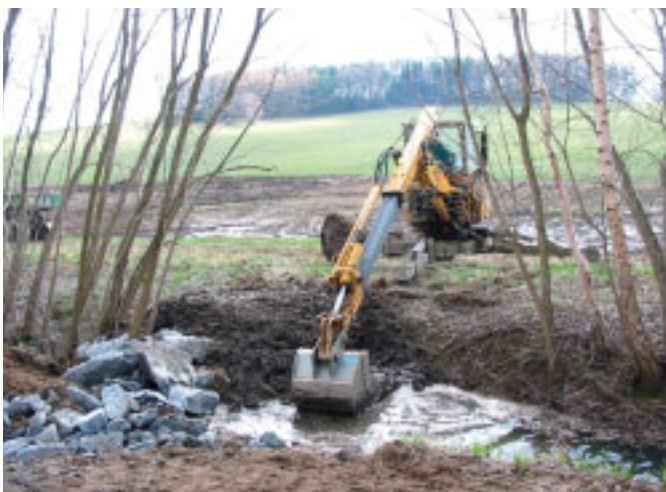
Jeden z vrcholných okamžiků revitalizace – původní koryto se zahrazuje kamenivem a zeminou, aby se průtok přeměroval do nového koryta, přírodě blízkého
