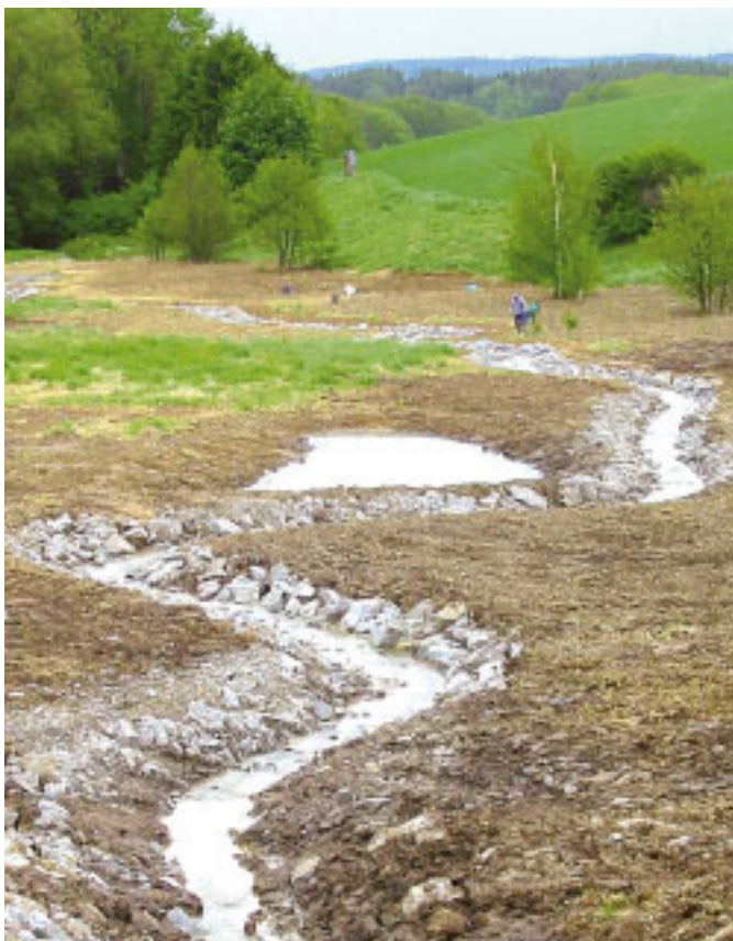
Dolní úsek revitalizační stavby v době dokončování - nové vlnité koryto, tůň
