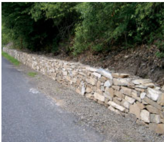
Obnovou na sucho skládaných kamenných zídek v PR Nezabudické skály se zamezuje padání sutí na vozovku a zároveň vzniká množství vhodných úkrytů pro přezimování i rozmnožování ještěrky zelené
