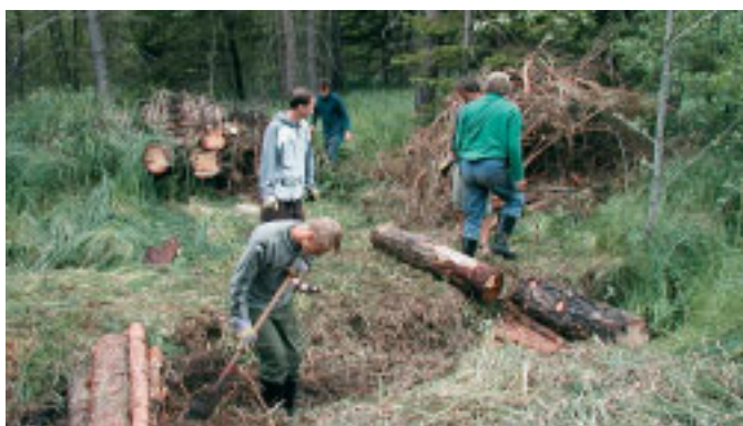
Stavba přehrádek v PR Prameny Klíčavy
