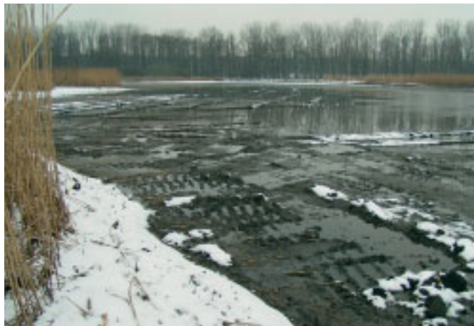
Odbahňování části Bohdanečského rybníka mezi Polákovým poloostrovem a západním břehem rybníka
